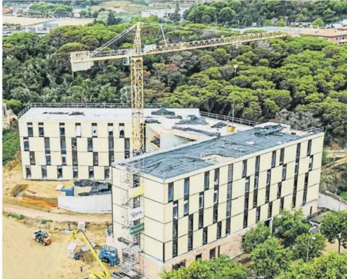
Los módulos se construyen en una fábrica de Huesca y luego se montan in situ
